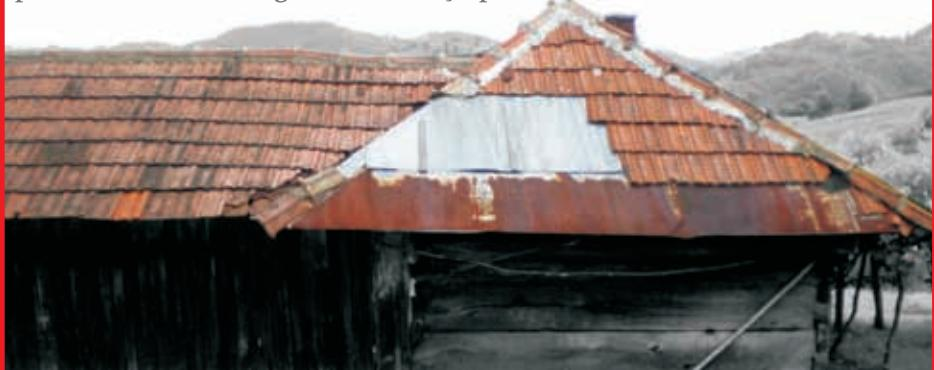
Nu se va utiliza învelitoare din tablă! (Dăunează structurii de lemn a șarpantei și a casei în general.)
