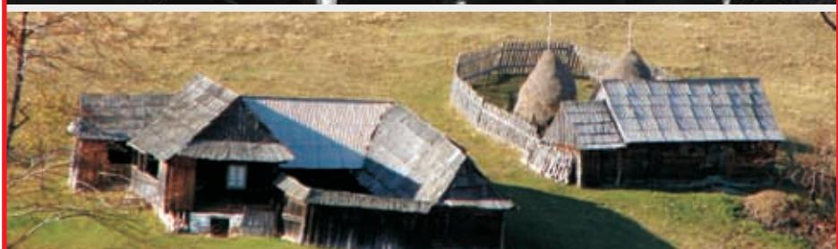
**Nu se va înlocui șindrila cu țiglă dacă structura șarpantei nu a fost adaptată să reziste greutății noii învelitori!** (afectează stabilitatea întregii structuri)
