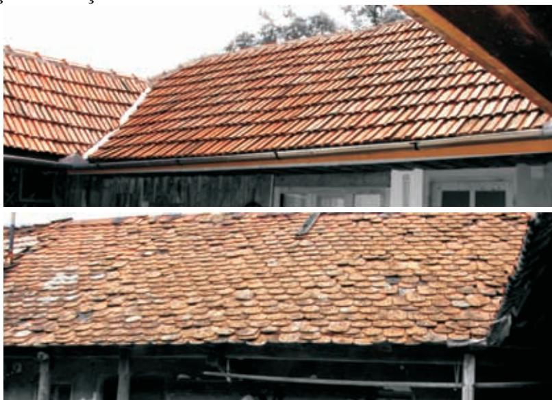
Nu se va asocia tabla cu țigla pe același acoperiș! (Si în aceasta situație tabla poate afecta destul de grav structura șarpantei.)
