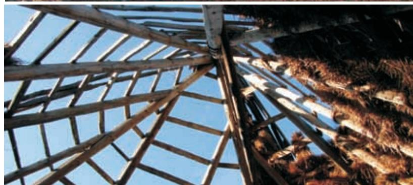
**NU se vor înlocui învelitorile din șindrilă sau paie cu alte învelitori neadecvate și nespecifice!** (Înlocuirea cu tablă poate afecta întreaga comportare în timp a structurii de lemn, împiedicând respirarea lemnului.)
