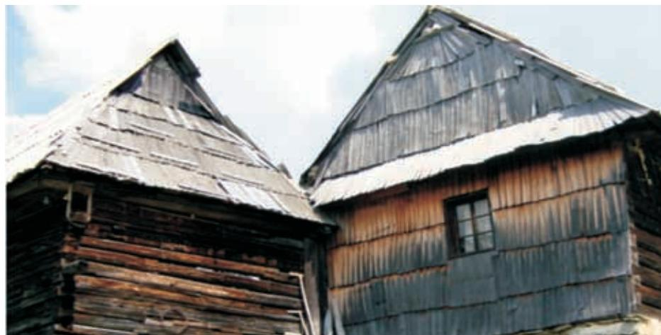
**Nu se va asocia tabla cu șindrila!** (Dacă șindrila a fost deteriorată, mai bine se înlocuiește tot cu șindrila. Tabla poate afecta destul de grav structura șarpantei modificând climatul interior de la nivelul podului: nu permite evacuarea fumului, uscarea elementelor umede și ‘respirarea’ elementelor de lemn, putând genera degradări biologice la nivelul acestora.)
