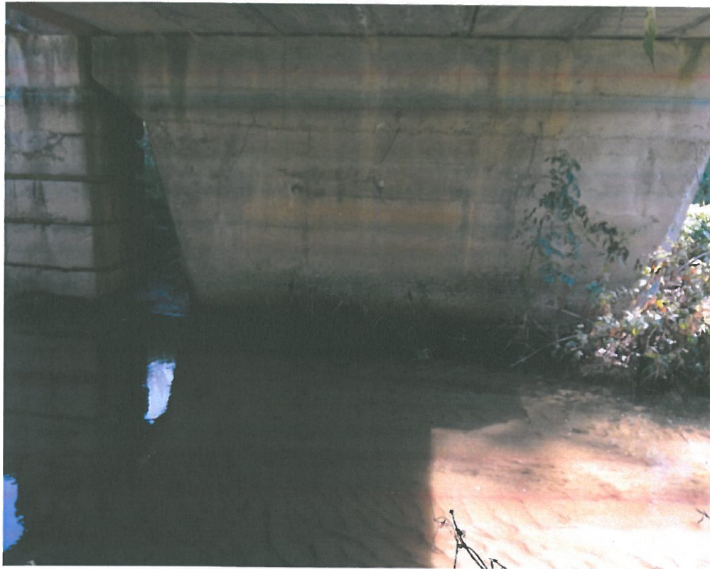
Foto 11: Pila este afuiata si subspalata pe partea dreapta
