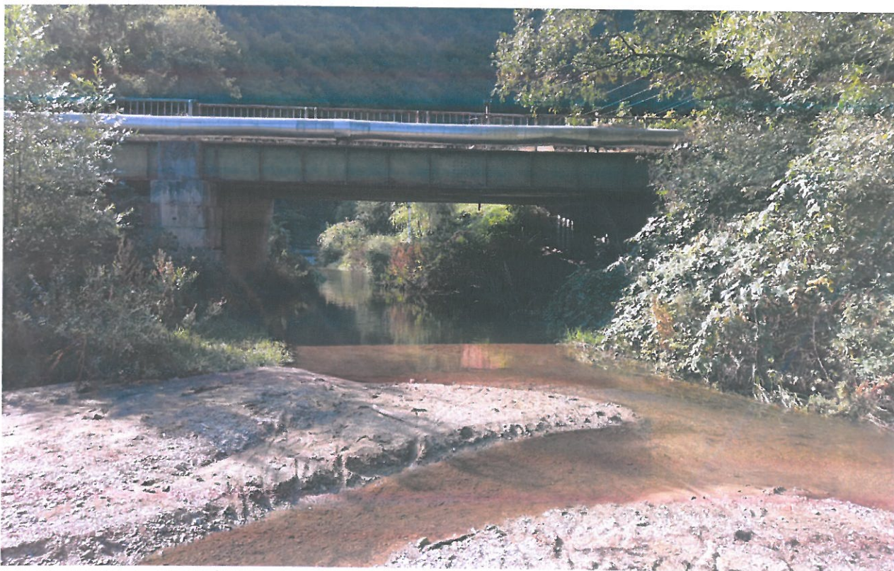
Foto 5: Vedere dinspre aval: structura de sustinere a celor doua tevi (apa si canalizare)
