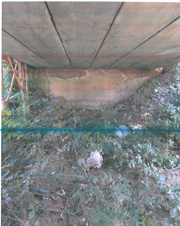
Foto 10: In albie sunt dedepuneri aluvionare, segregari si carbonatari ale betonului culeei
