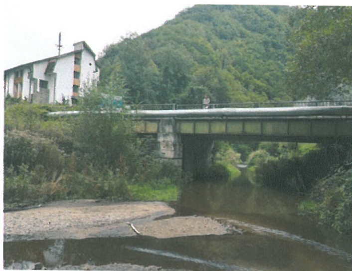
Fig. 2. Podul peste valea Sebeș (vedere din aval)
