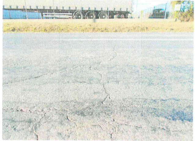
Sectoare de drum cu defecțiuni de tipul fisurilor și crăpăturilor pe mai multe direcții
