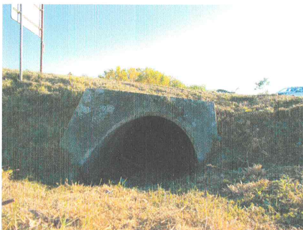
Podet ovoidal colmatat fără amenajare amonte și aval
