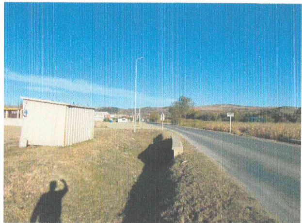
Sectoare de drum cu șanțuri fără continuitate în zona acceselor la proprietăți
