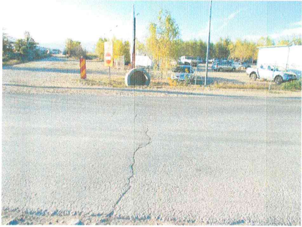
Sectoare de drum cu defecțiuni de tipul fisurilor și crăpăturilor pe mai multe direcții
