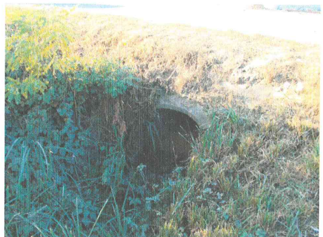
Podet ovoidal colmatat fără amenajare amonte și aval
