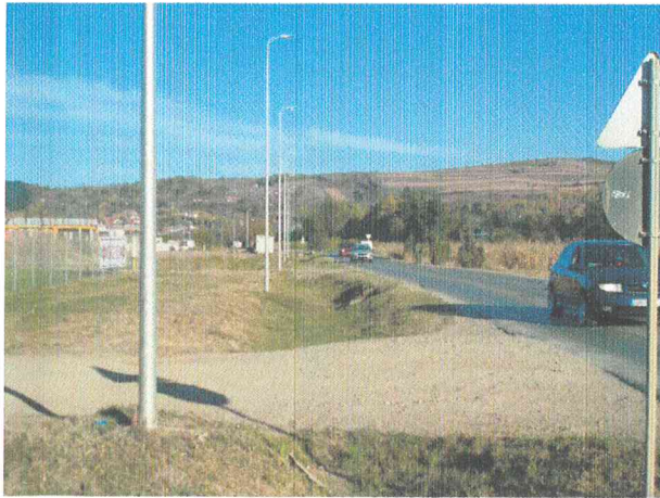
Sectoare de drum cu șanțuri fără continuitate în zona acceselor la proprietăți
