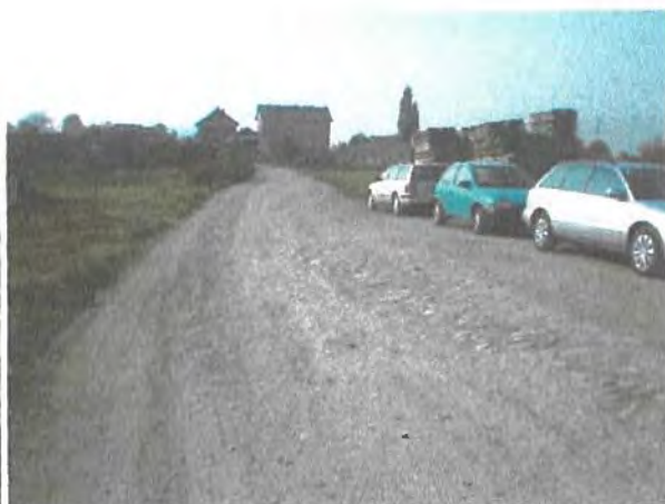
Sectoare de drum cu defecțiuni de tipul fâgașelor și gropilor
