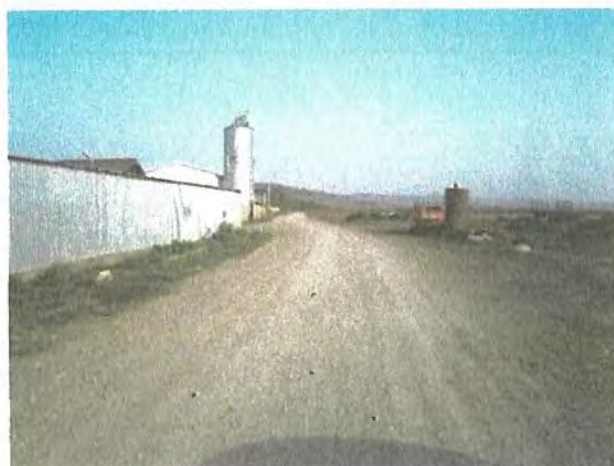
Sector drum fără dispozitive de colectare a apelor pluviale
