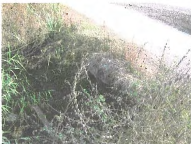
Poduț dalat colmatat cu suprastructură degradată fără amenajare amonte și aval
