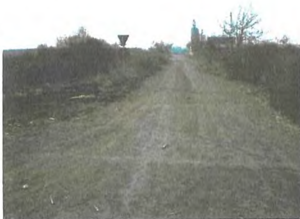
Sectoare de drum cu defecțiuni de tipul fâgașelor și gropilor
