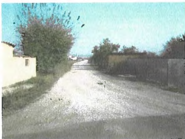
Sector drum fără dispozitive de colectare a apelor pluviale
